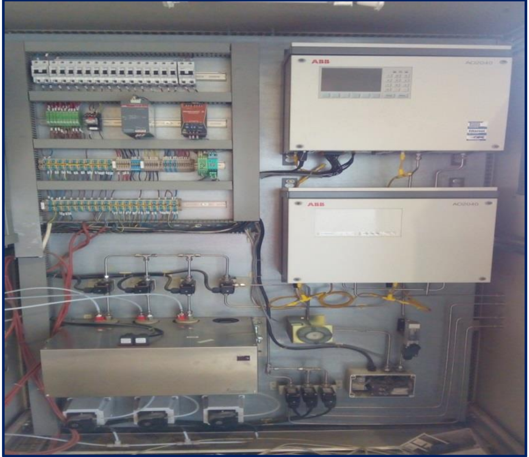
Resim 9: Çevrimiçi gaz analiz cihazı
