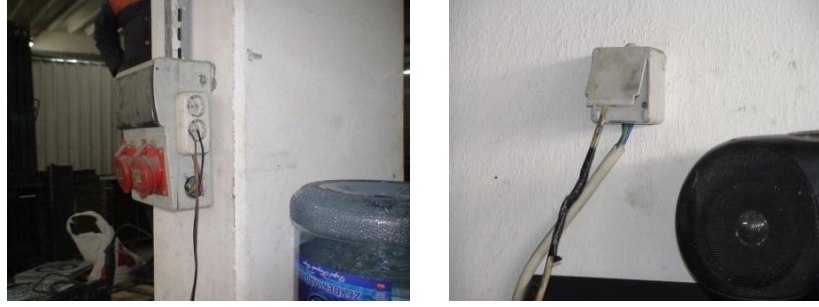
Resim 57 : Deforme olmuş sigorta
