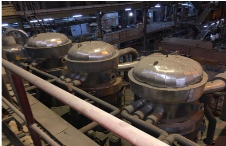
Şekil 3.11: Alçak ve Yüksek Basınç Isıtıcıları
