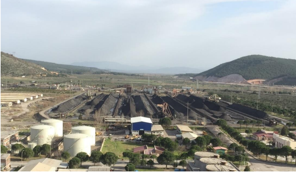
Şekil 3.3: Stok Sahası (Bunker)
