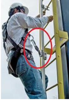
Şekil 40: Sökülüp takılabilen ankrajlar
