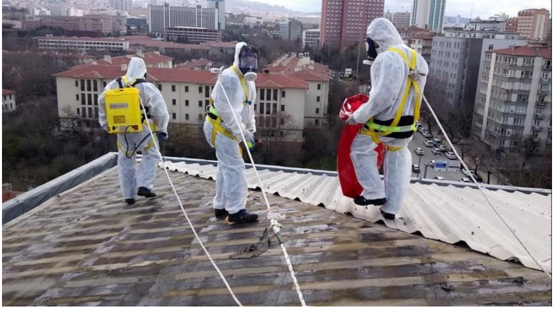
Resim 3. 2 Çatıda Asbest Temizleme İşlemi Yapan Çalışanlar
