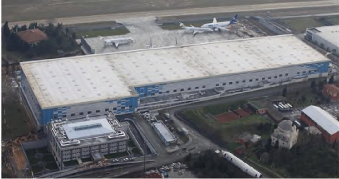
Resim 1: Uçak bakım - onarım hangarları
