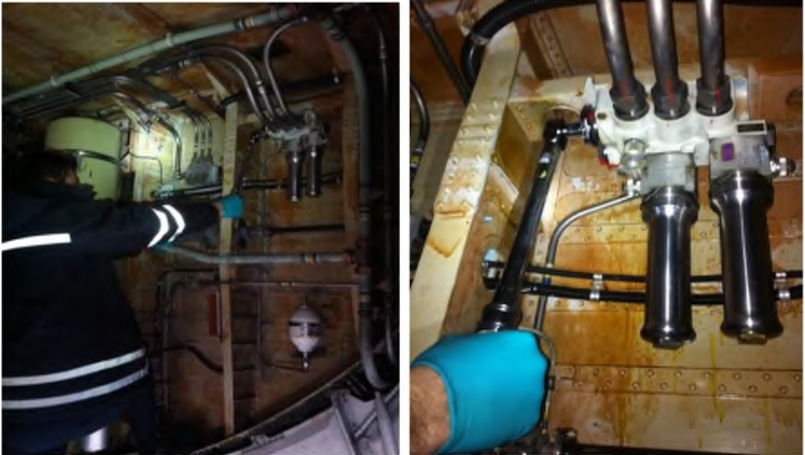
Resim 91: Ulaşımı zor olan bölgelerde torkmetre ve ay anahtar ile yapılan çalışmalar
