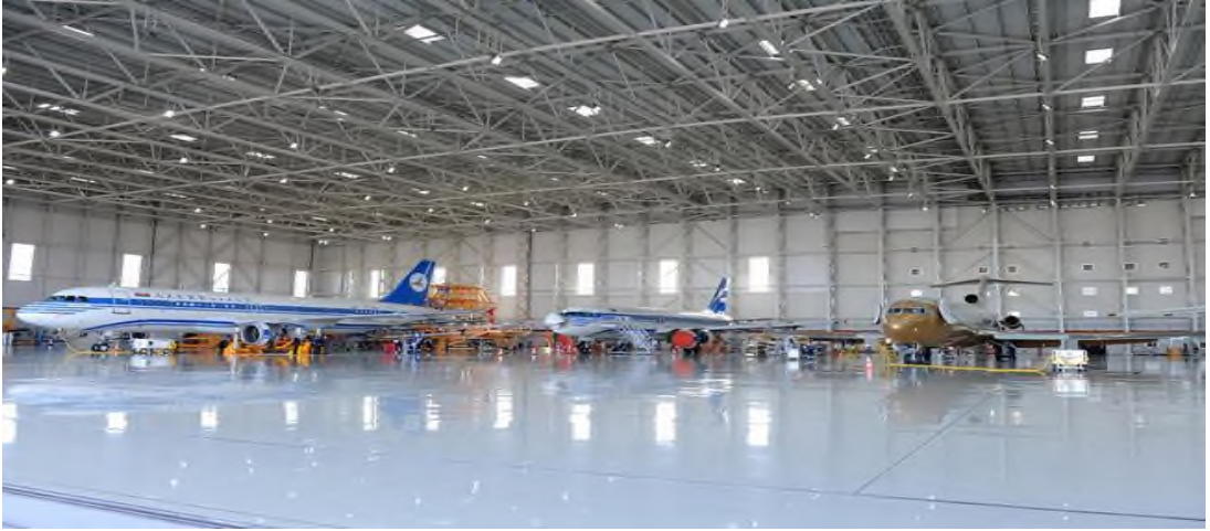
Resim 63: Uygun ışık kaynağı, zemin ve çatı dizaynı ile aydınlatılmış uçak bakım hangarı
