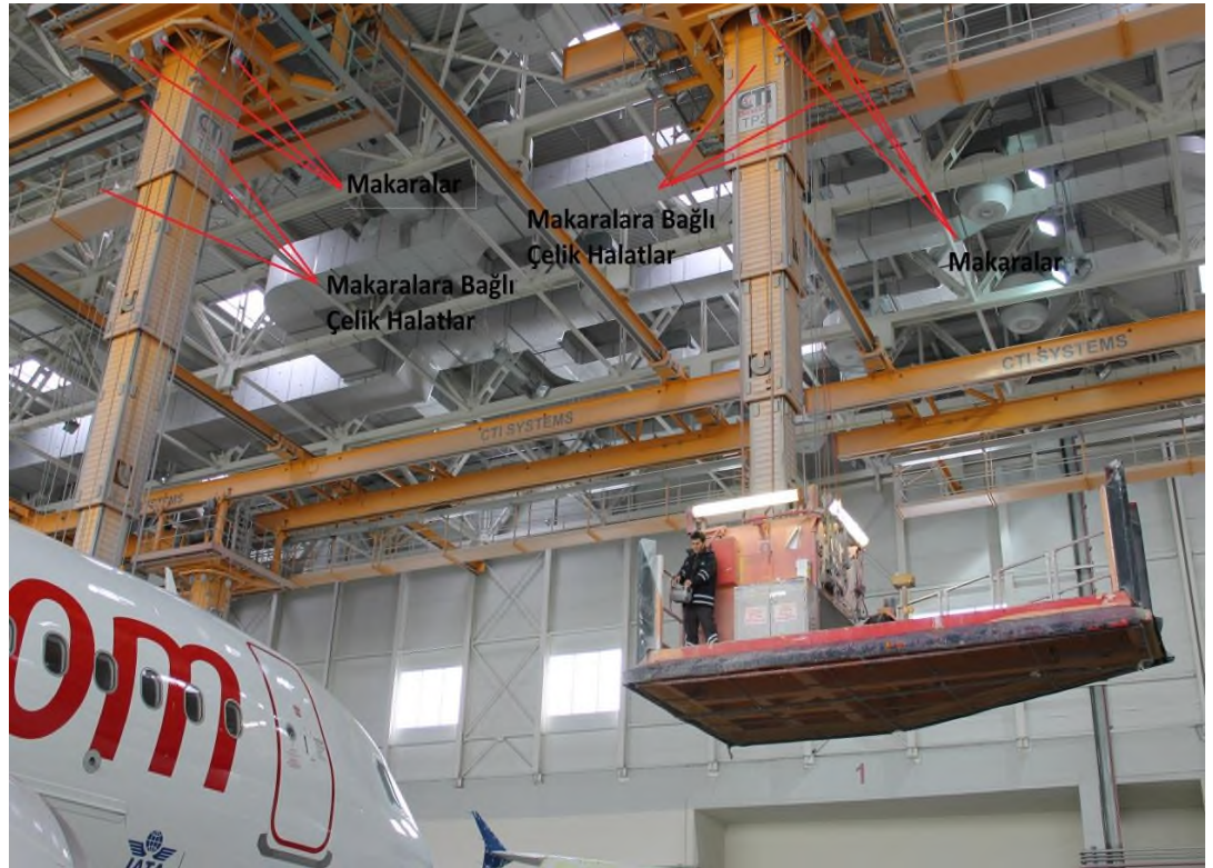
Resim 79: Teleplatform üzerinde emniyet kemerlerinin rahatça bađlanabileceđi çelik halatlar
