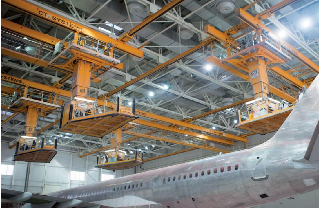
Resim 78: Hangar tavanına bađlı raylar üzerinde hareket ettirilen teleplatformlar
