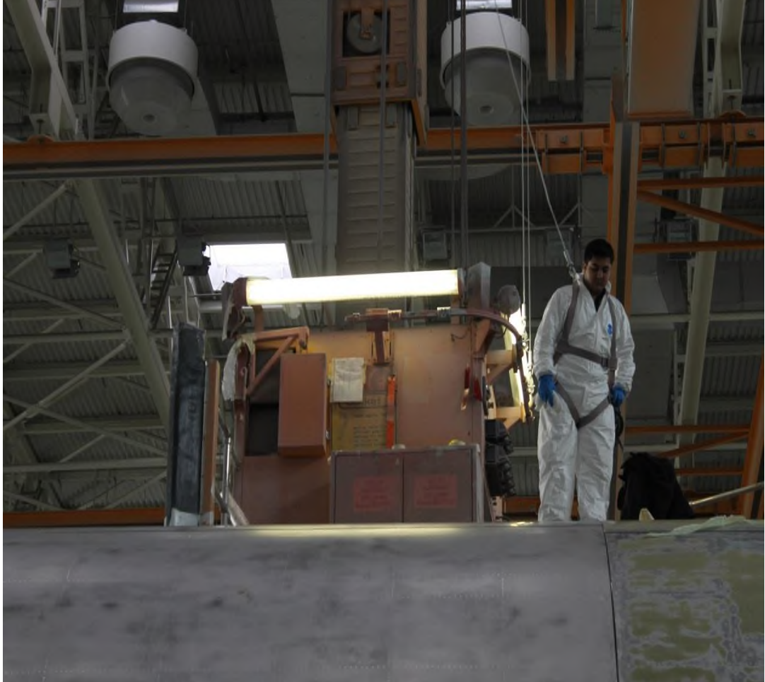
Resim 80: Aydınlatma ve düşüş emniyet sistemleri teleplatformların en önemli donanımlarındandır
