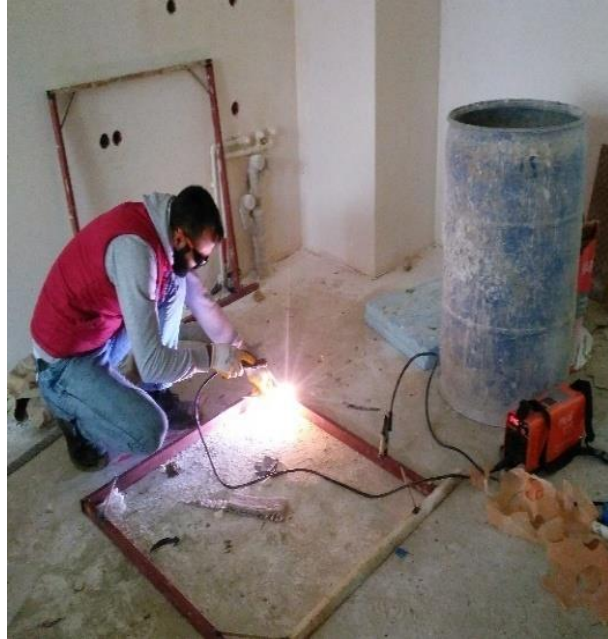
Resim 2.4. Elektrik ark kaynağı
