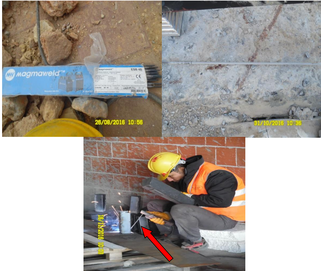
Resim 2.24. Çubuk elektrot
