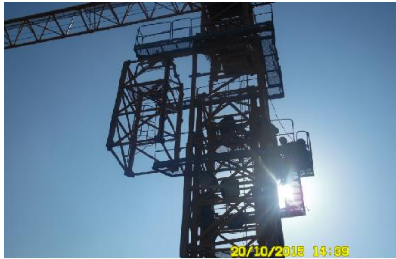
Şekil 21: Kule Vinç Gövde Yükseltme Çalışması.
