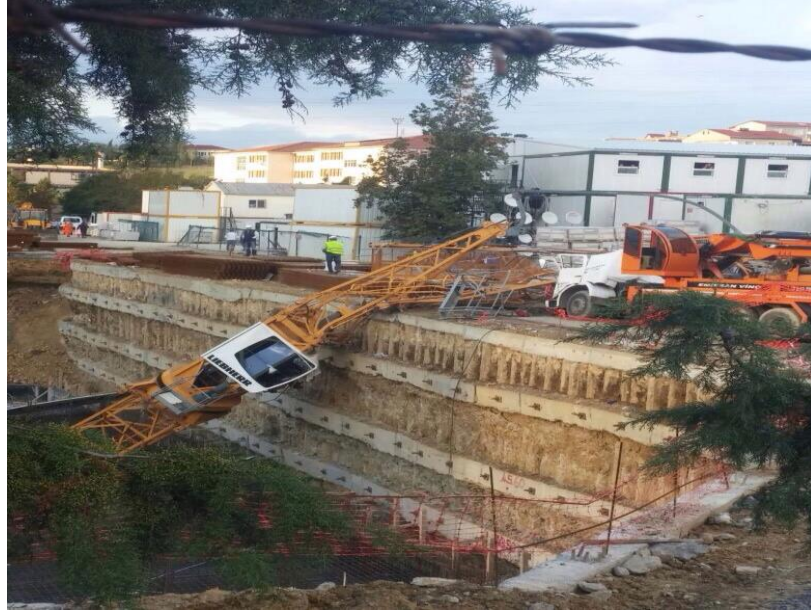
Şekil 25: Örnek Kule Vinç Kazası (Altınöz, Uzun, Bahadır, Sarmusak ve Karagöz, 2011).
