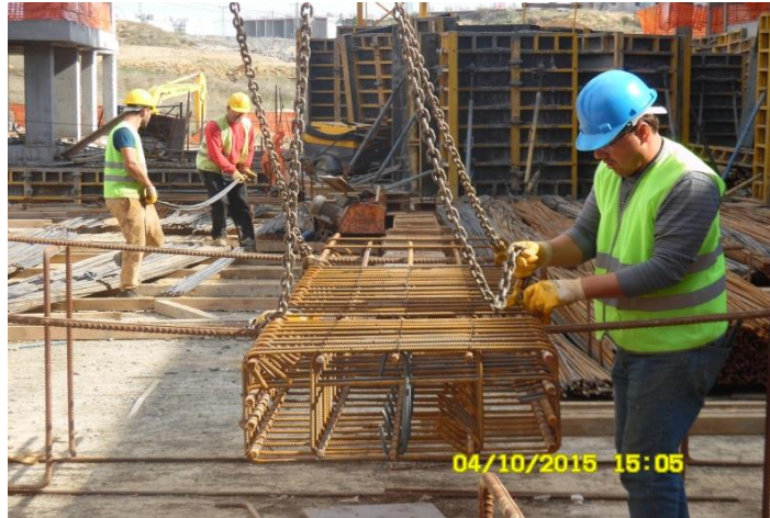
Şekil 23: İşaretçinin Malzemeleri Kule Vincin Kancalarına Bağlaması.
