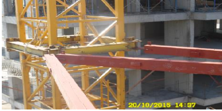
Şekil 20: Kule Vinç Bina Bağlantısı.
