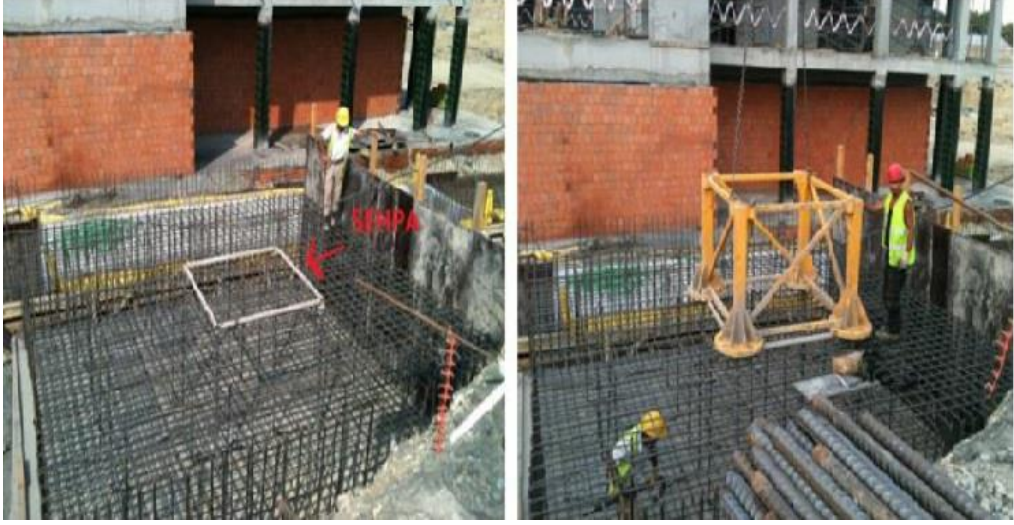
Şekil 17: Kule Vinç Kurulumu (ADV, 2015).
