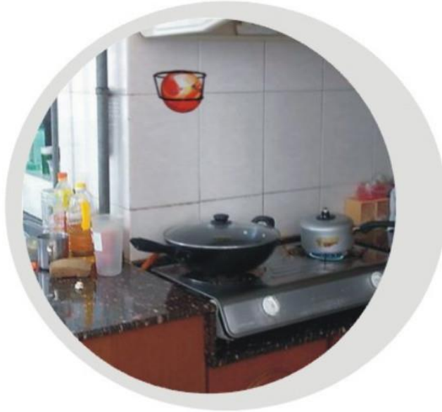
Resim-5.8. Yangın topunun mutfakta uygulanması.
