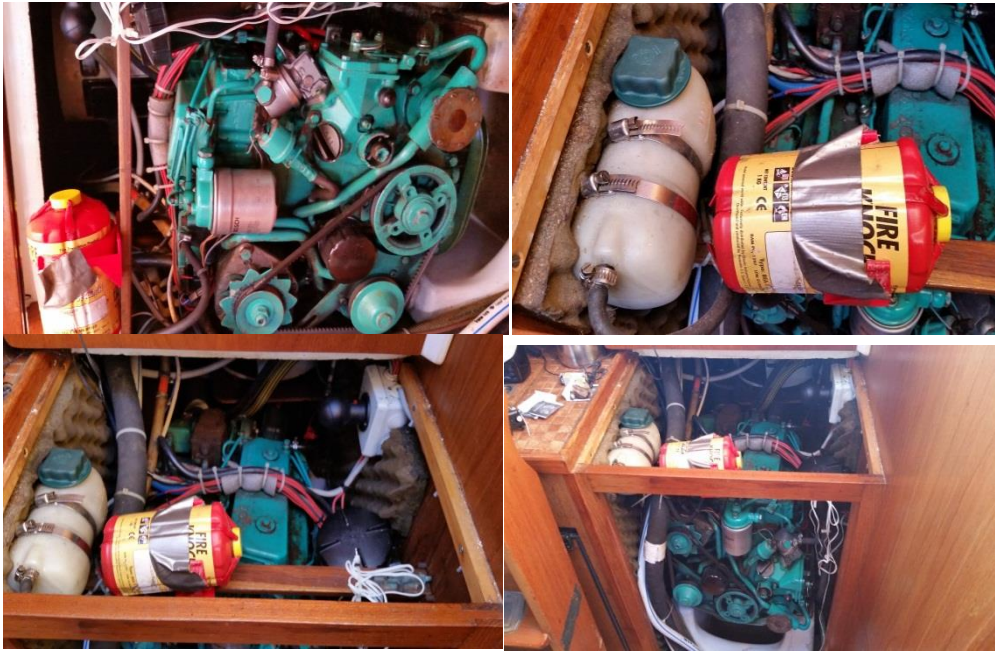
Resim-5.12. Özel teknenin makine bölümünde yangın topu uygulaması (17 Aralık 2016 tarihinde çekilmiştir)
