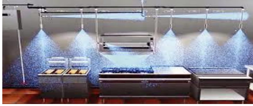
Resim-5.5. Mutfakta uygulanan sabit yangın söndürme sistemi-1
