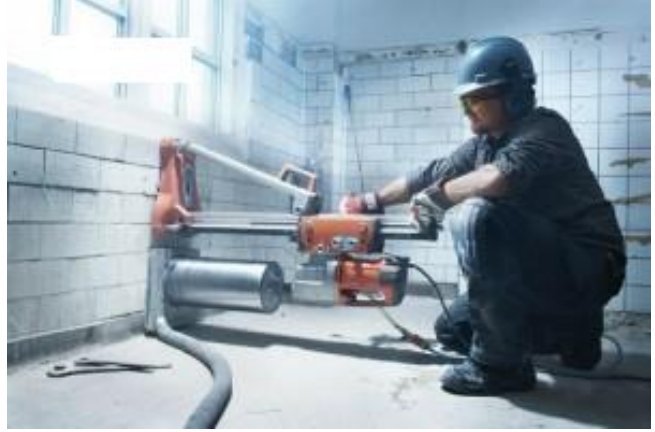
Şekil 3.1 : Beton delme (karot) makinası ve beton delme uygulaması.
