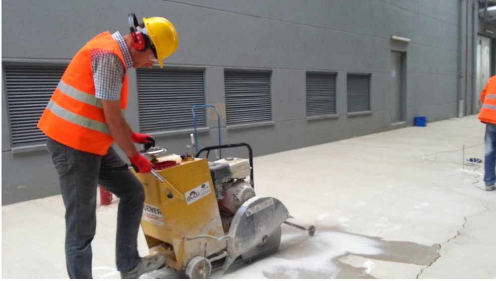
Şekil 3.3 : Yer (Derz) kesme uygulaması.
