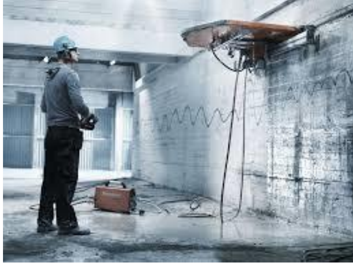
Şekil 3.2 : Raylı (Hidrolik) beton kesme uygulaması.
