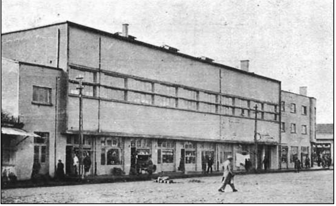
Şekil 4.16: Eskişehir Halkevi Binası Cephe Görünümü
