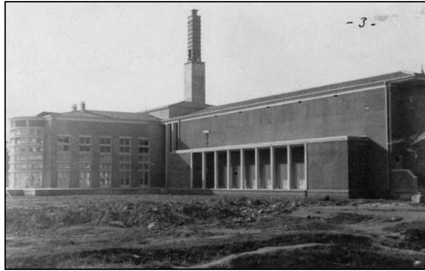
Őekil 4.28: İzmit Halkevi Binasının Kolonatl  GiriŐi
