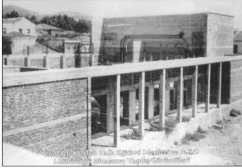
Şekil 5.11: İzmit Halkevi Binasının Yapımı
