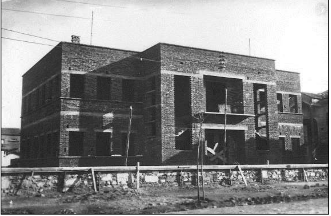
Şekil 4.23: Turgutlu Halkevi Binasının Yapımı
