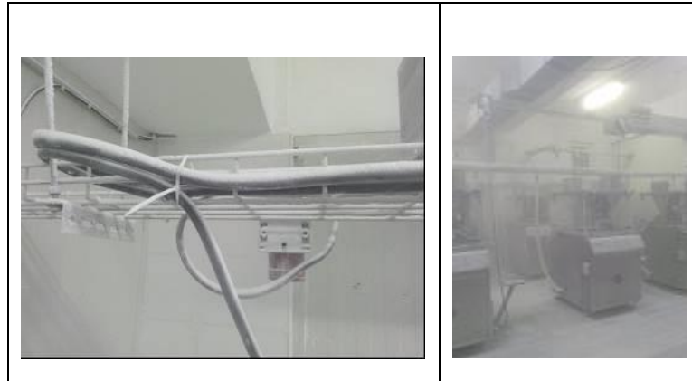
Resim 12: Şeker baskı ünitesinde toz birikimi (İstanbul 2015)
