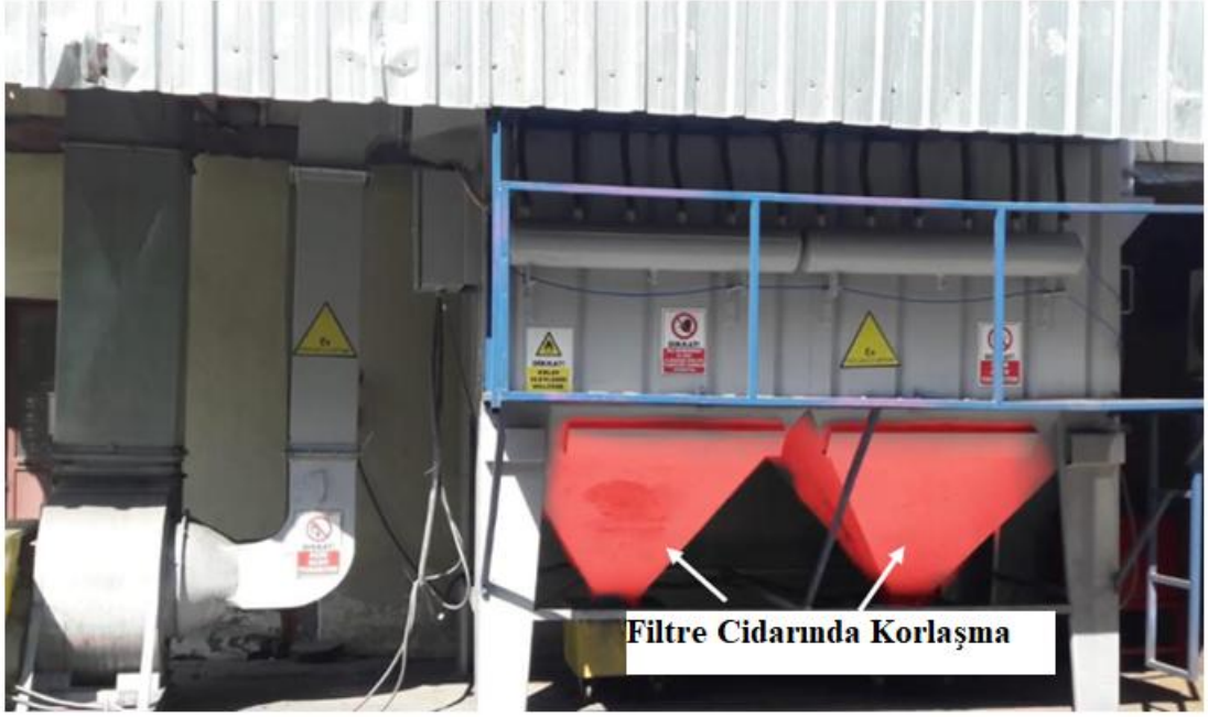
Şekil 7.14. Tesis 2 (Manisa) Filtre Cidarında Meydana Gelen Korlaşma
