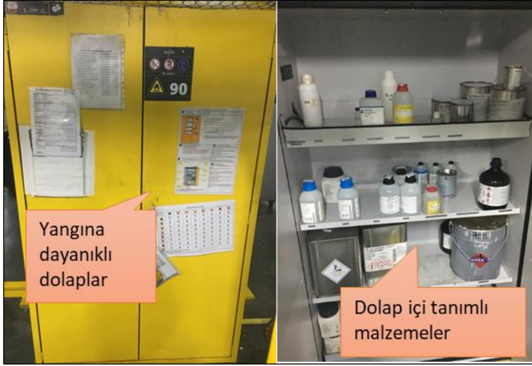
Şekil 5.28: Kimyasal depolama dolapları
