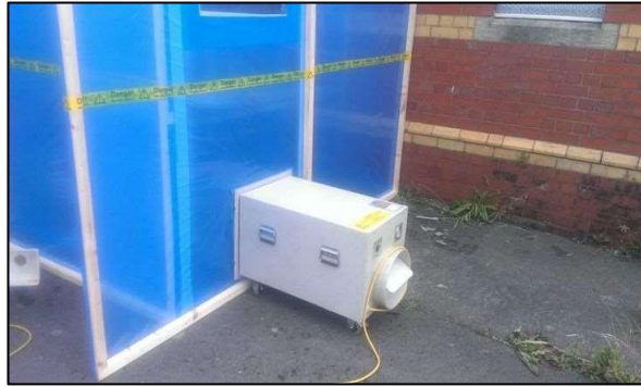
Resim 8.3 Negatif basınç ünitesi (İSGÜM,2016).
