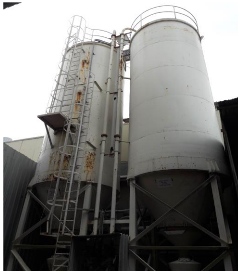
Şekil 5.43: Vaka 6 da Anlatılan Ramak Kalanın Yaşandığı Kalsit ve Barit Siloları
