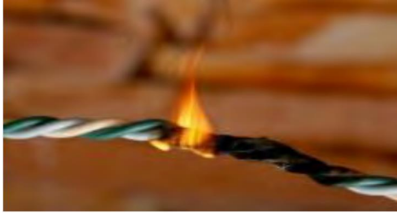
Şekil 5.16: Kabloda Aşırı Akıma Bağlı Isınma ve Tutuşma [19]
