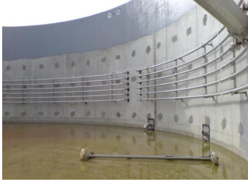
Şekil 2.9 : Dahili ısı eşanjörlü reaktör iç dizaynı
