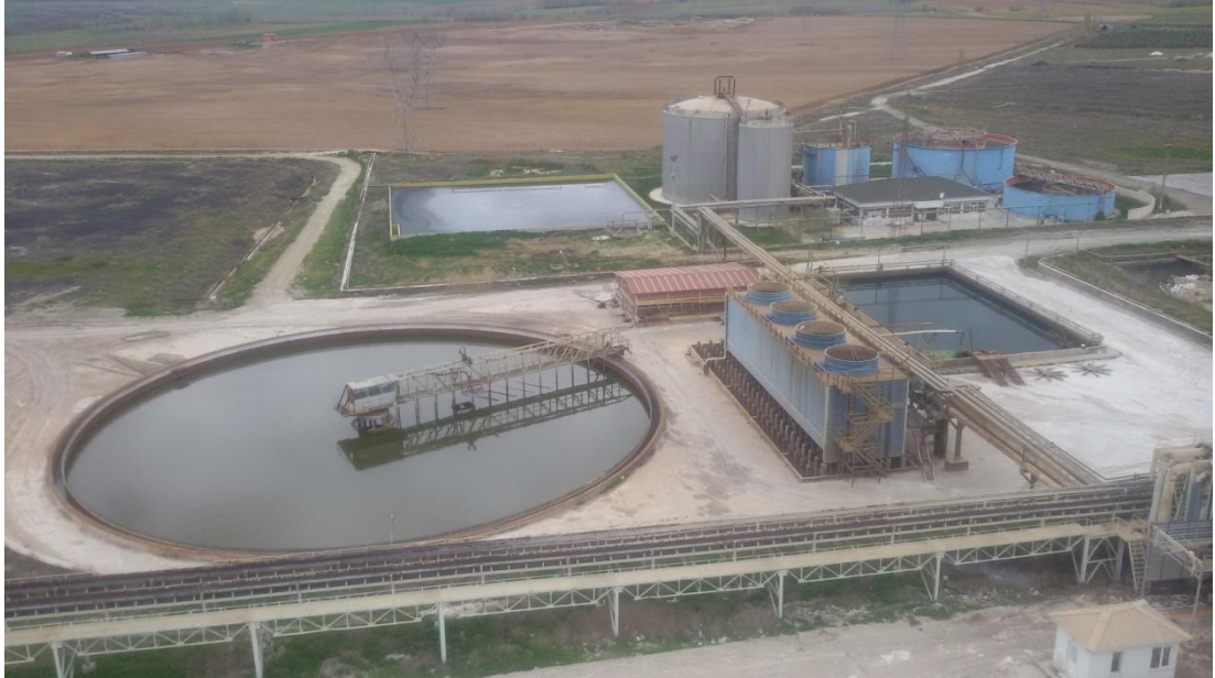
Resim 2.17. Atık Su Arıtım Tesisi
